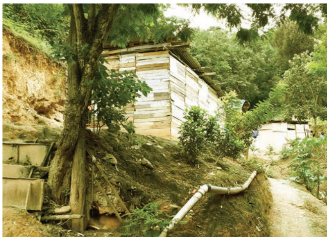
Typowy dom z doprowadzoną kanalizacją i wodociągiem.
